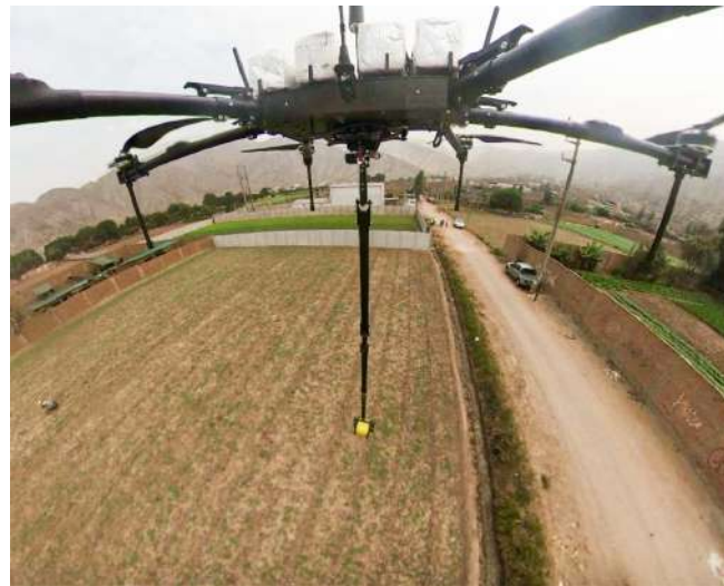
OX Tendido de cables
