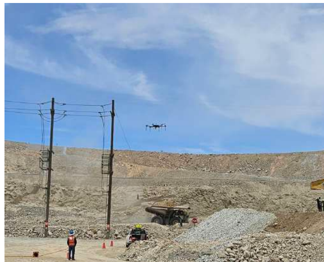
OX Termografía - Supervisión de tendido eléctrico
