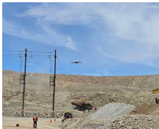
OX Termografía - Supervisión de tendido eléctrico
